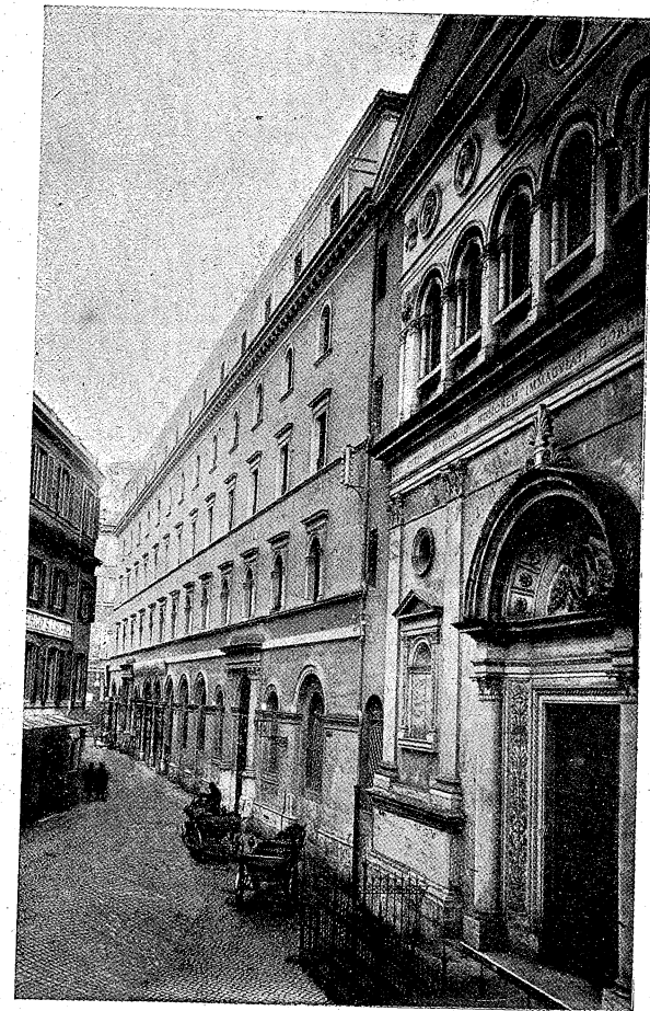
Façade du Séminaire français, via Santa Chiara.
