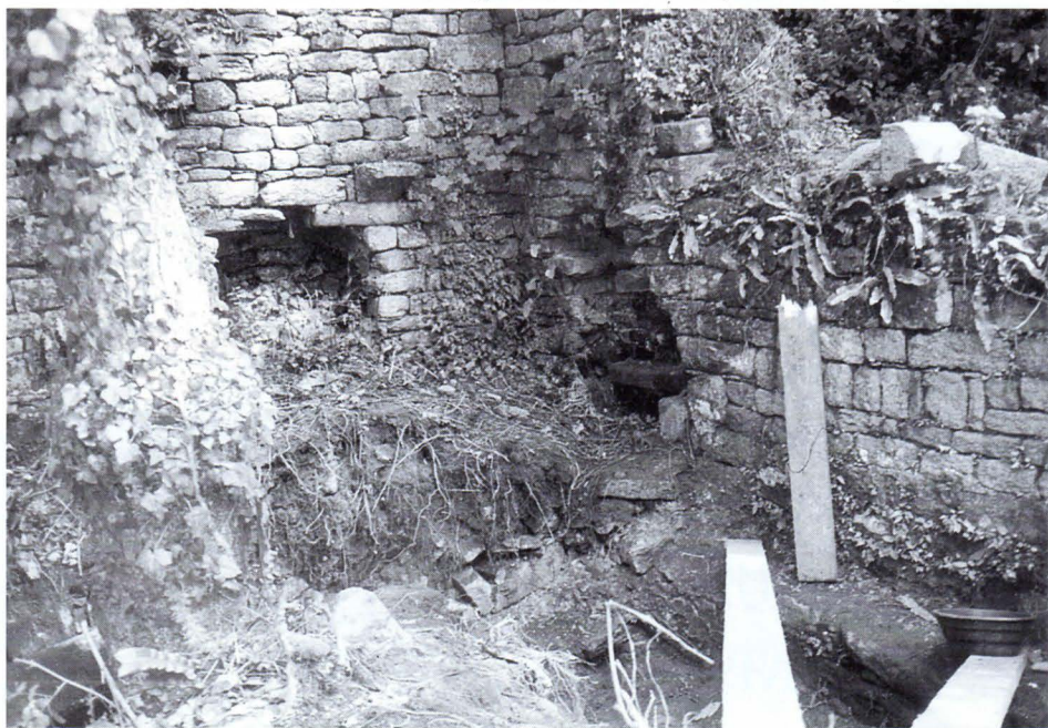
La végétation débroussaillée, le sol de la chapelle retrouvé.
