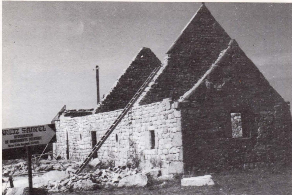
État actuel des travaux effectués sur les ruines de la chapelle Saint-Oursal. (Photo Per Peron).
