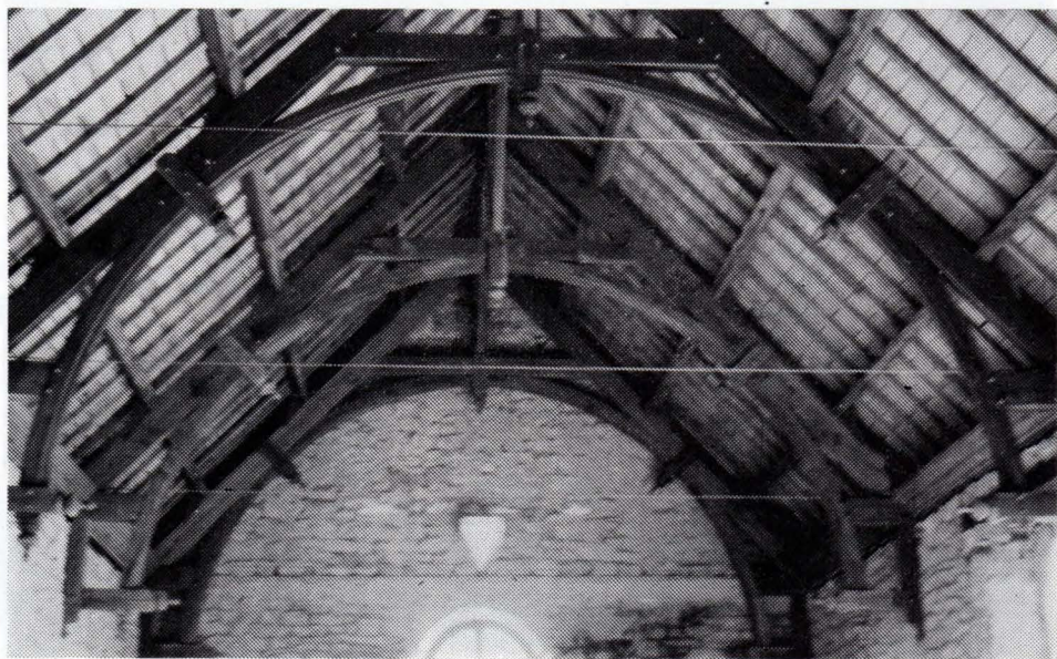
La charpente de la chapelle des Sept-Saints.
