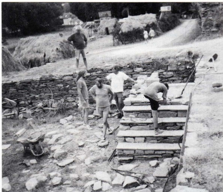
Construction d'un escalier au mur de l'enceinte.
