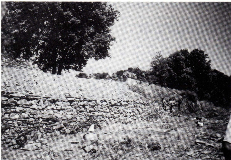
Les murs de l'enceinte remis en état.
