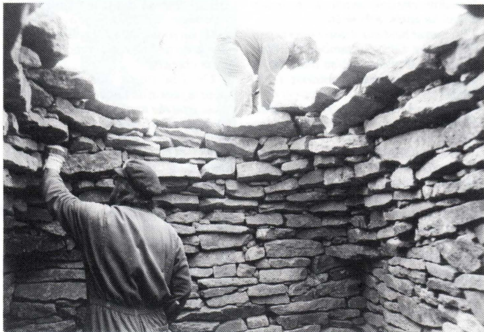
En avril 1996. Naissance de la voûte en encorbellement par M. Fichou et un stagiaire.
