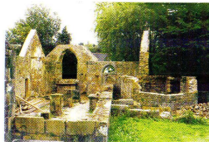
APRÈS LES TRAVAUX DE L'ÉTÉ 1998
