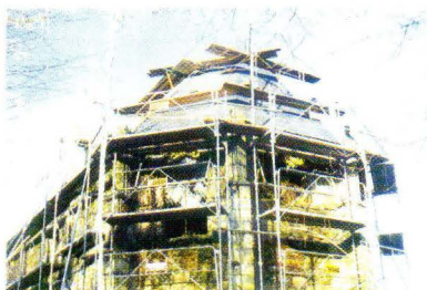
PENDANT LA POSE DE LA COUVERTURE
