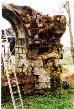
PLUSIEURS GROS ARBRES AVAIENT PUSSES DANS LES MURS CALPAINGE DES PIERRES AVANT LE REMONTAGE
