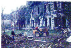
DEFRICHAGE DES MURS
