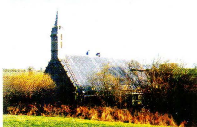
JANVIER 2002 : POSE DE LA COUVERTURE
