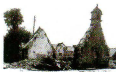
L'ÉTAT DE LA CHAPELLE APRÈS LES BOMBARDEMENTS
