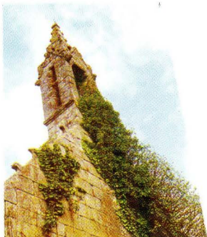
LE PIGNON OUEST ET LE CLOCHER AVANT LES TRAVAUX
