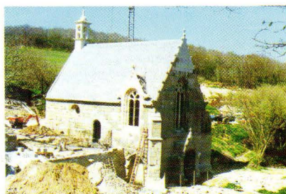
COUVERTURE EN VIEILLES ARDOISES DE RÉCUPÉRATION
