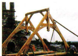
LA NOUVELLE CHARPENTE EN COURS DE POSE (1995)
