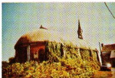
L'ETAT DU BATIMENT EN 1994 : AVANT LES TRAVAUX
