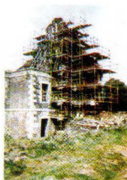
CONSOLIDATION DU PIGNON SUD DE L'ABBATIALE PAR LES M.H.
