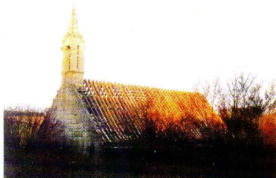
DÉCEMBRE 2001 : POSE DE LA CHARPENTE
