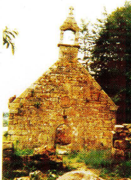
LA FACADE OUEST AVANT TRAVAUX (1993)
