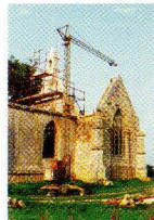
1994 : LA RECONSTRUCTION DU PIGNON CENTRAL AVEC CLOCHETON
