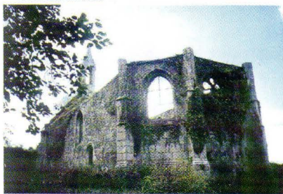
LA CHAPELLE AVANT TRAVAUX, VUE DU SUD - EST
