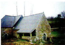
APRÈS LA RESTAURATION
