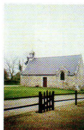
LA CHAPELLE RESTAURÉE
