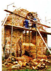
LA MISE EN PLACE DE LA FENÊTRE EST ET SON REMPLAGE
