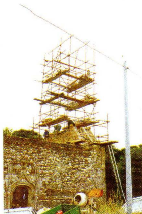
DÉMONTAGE ET REMONTAGE À L'IDENTIQUE DU PIGNON (EN COURS)
