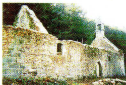
APRÈS CONSOLIDATION DES MURS EN 1993
