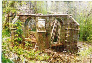
LE CHOEUR RESTAURE APRES DEMONTAGE ET REMONTAGE
