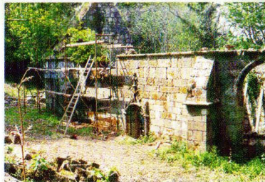
UNE PARTIE DU MUR SUD AVEC LA PORTE DE NOUVEAU DEBOUT
