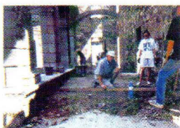
REMISE A NIVEAU DU SOL DANS LE CLOITRE
