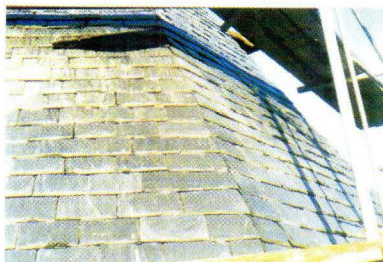
DETAIL DE LA COUVERTURE, EN ARDOISES EPAISSES
