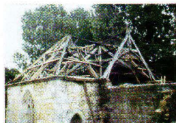
PENDANT LA DÉPOSE DE LA COUVERTURE.
