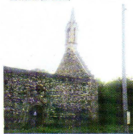
LA CHAPELLE APRÈS LES TRAVAUX DE MAÇONNERIE
