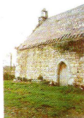
L'ANCIENNE CHARPENTE ET TOITURE DE 1900 AVANT DÉMOLITION
