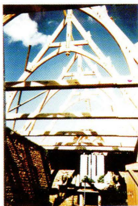
POSE DE LA CHARPENTE
