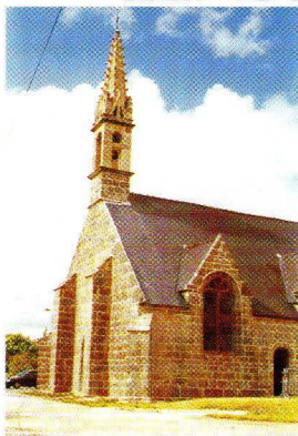
LE CLOCHER ET LA CHAPELLE APRES TRAVAUX
