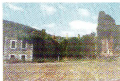
LES RUINES DE L'ABBAYE AVANT TRAVAUX
