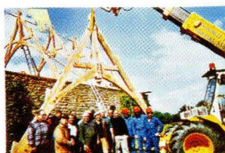
POSE DE LA CHARPENTE
