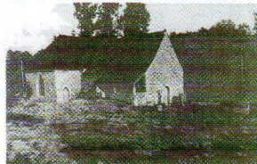
LA CHAPELLE DE LOCMELTRO VUE D'EN HAUT, À LA FIN DU XIXE SIÈCLE.
