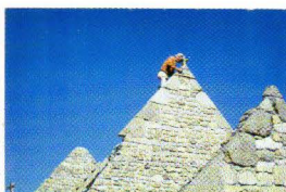
PENDANT LE REMONTAGE DES MURS
