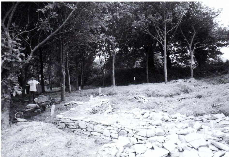
Le début des travaux.
