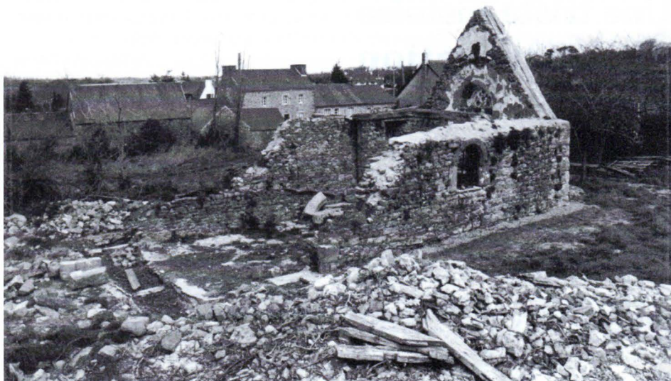
Les travaux de réfection ont commencé. Le toit a été enlevé et les pierres sont triées et classées.
