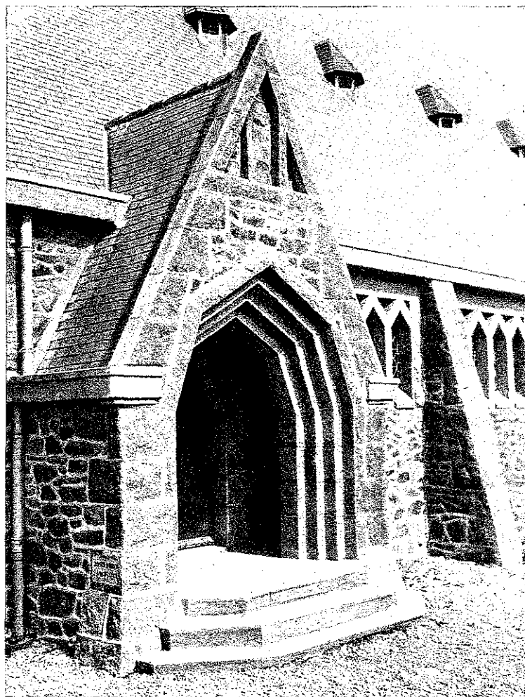
Fig. 23. — Eglise de Larmor. — Le porche.
