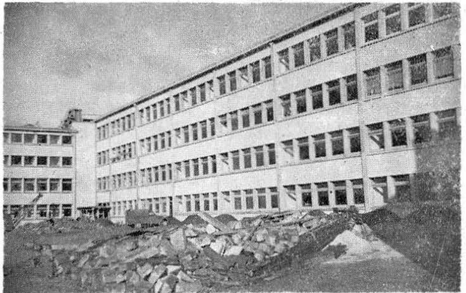
La nouvelle façade principale du Likès est terminée depuis février. L'entreprise Le Eris procède maintenant à l'aménagement de la cour d'honneur.
