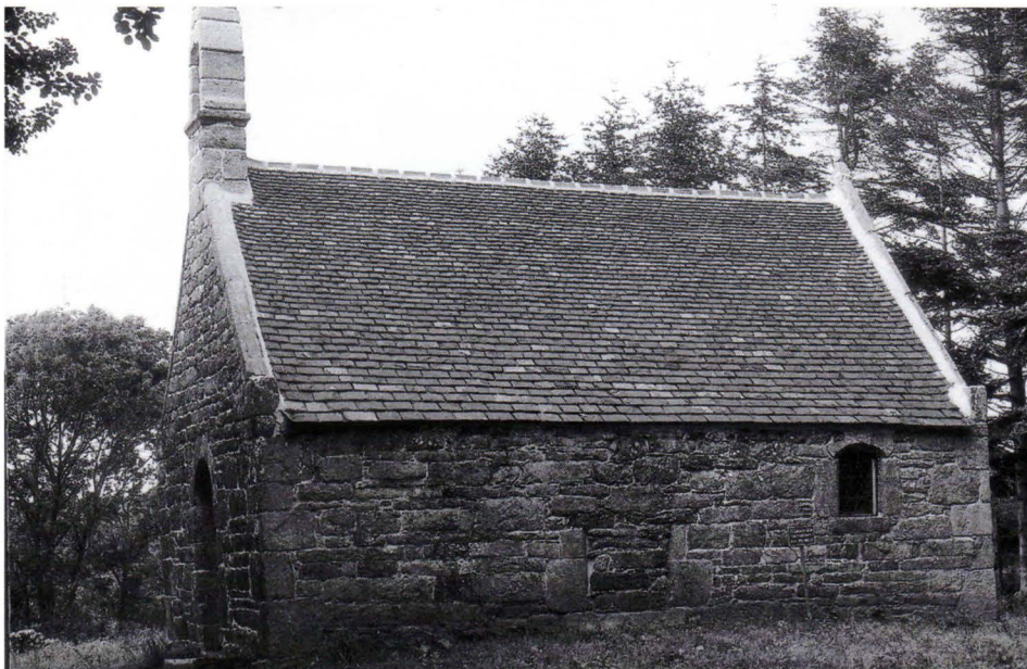
L'état de la chapelle en juin 2007.
