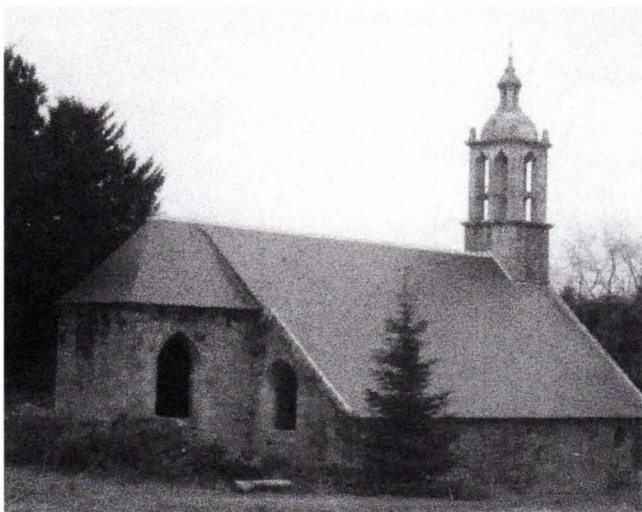
La chapelle lors de la cérémonie de fin des travaux de couverture en février 2006.
