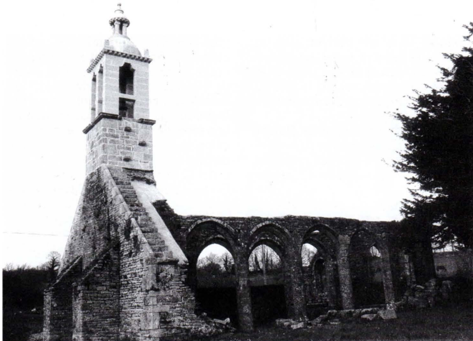
Le clocher après la restauration.
