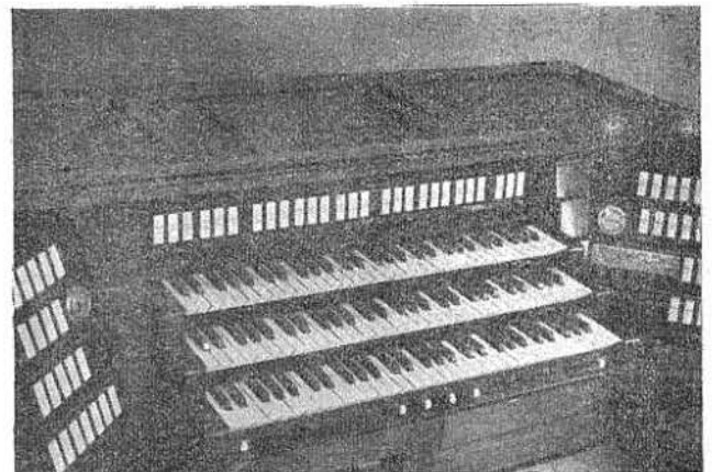
La console, âme de l'instrument, comprend les trois claviers manuels, l'appel des jeux, les combinaisons de timbres et le pédalier. Chaque manuel compte 61 notes ; la pédale, 32 notes.
