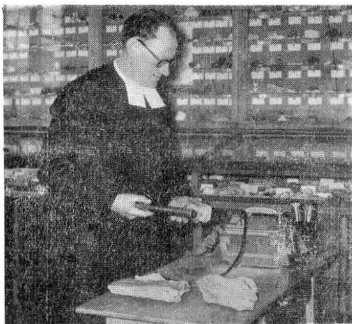
Le compteur Geiger-Müller permet de détecter à coup sûr la radio-activité des roches : c'est un appareil courant de recherche.
