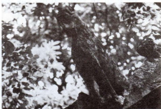
Crossette sud-ouest de la nef
