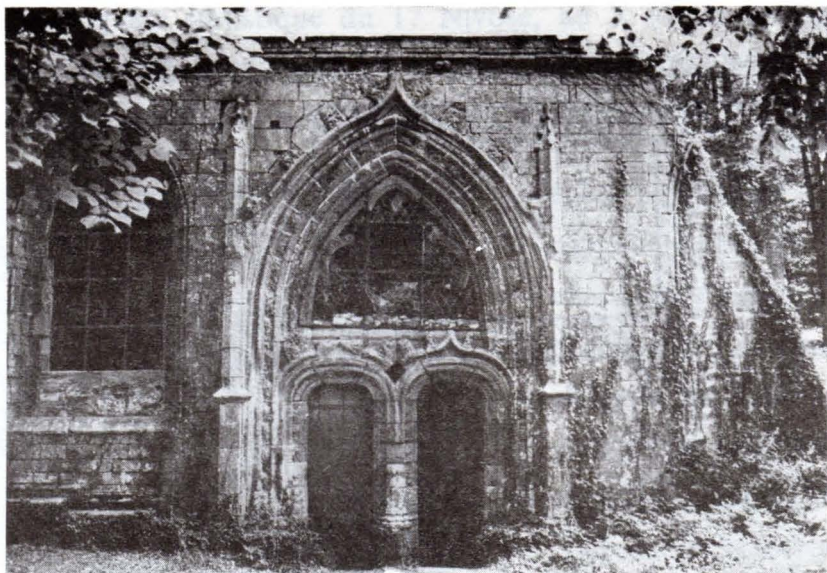
Portail sud de la nef à double baie et tympan ajouré
