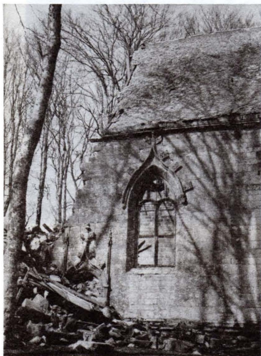
Vue sud du chœur après l'effondrement de la tour en 1931 (Coll. A.D.M.)
