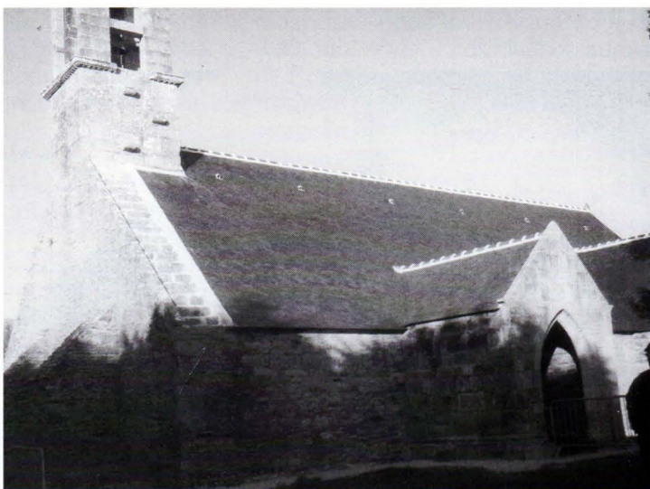
La chapelle de Trébalay après la restauration de la toiture.
