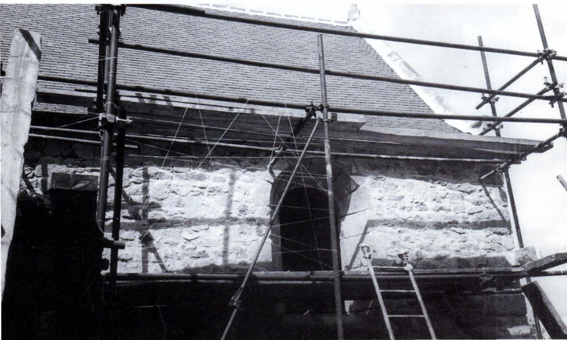
Le rejointement du mur Sud du chœur par les Caravelles de Lyon.
