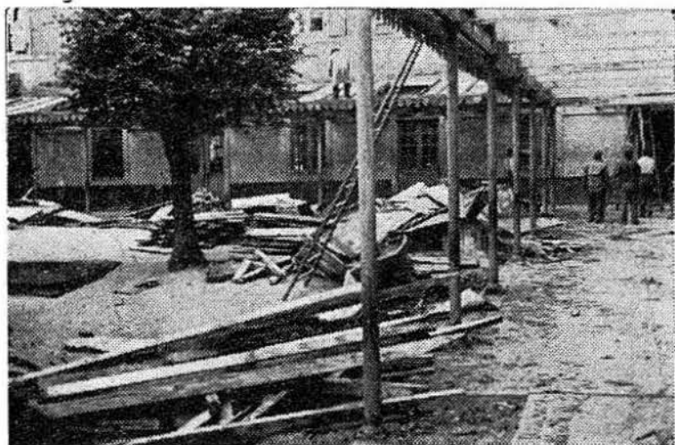
Les « démolisseurs » aux prises avec l'ancien préau (Juillet 1948)
