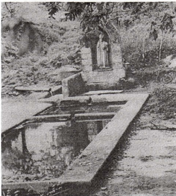
La fontaine durant les travaux
