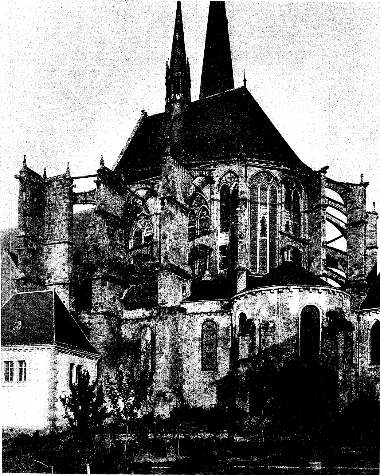
EGLISE DE GALLARDON : ABSIDE SUD.
