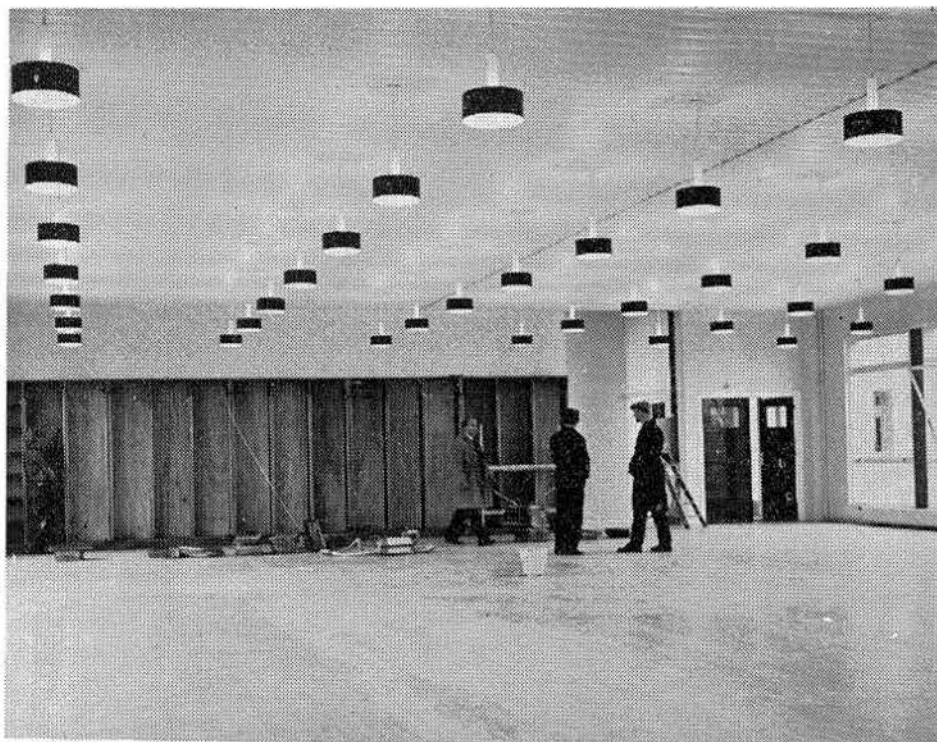
Depuis le 1 er février, le local de la Bibliothèque du Second Cycle est terminé ; la menuiserie du Likès procède à son équipement en tables et rayonnages
