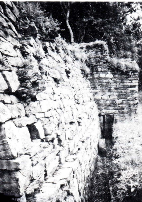
Le mur d'enceinte et la canalisation des eaux
