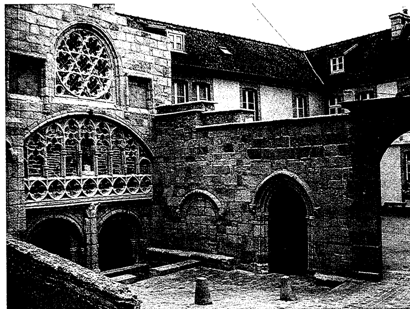
Restes du Transept nord de Notre-Dame de la Fontaine.
