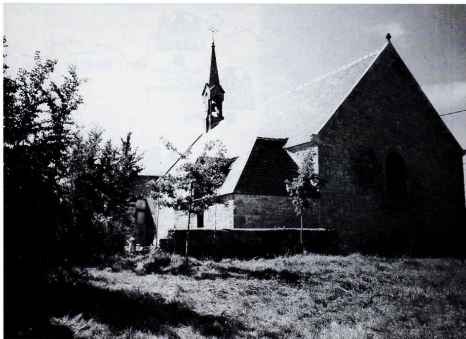
La chapelle des Sept-Saints à Erdeven après sa rénovation.
