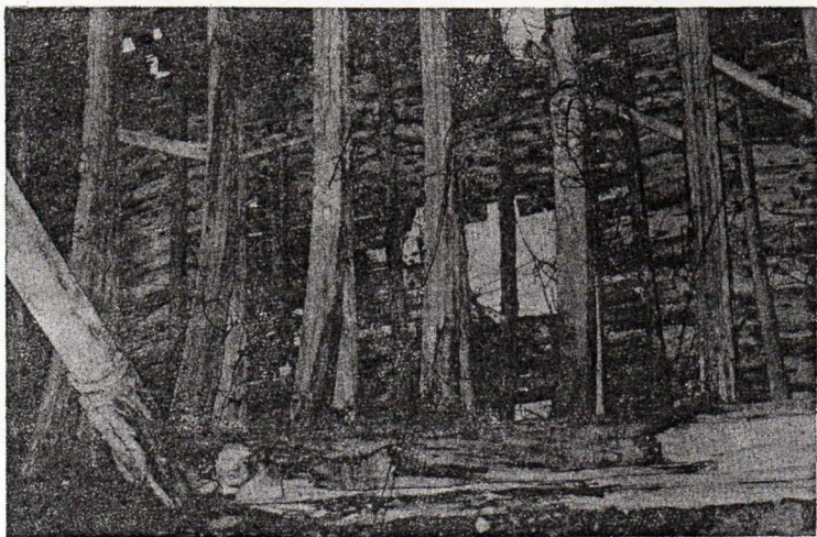
Requiem pour la charpente de 1455 ?
