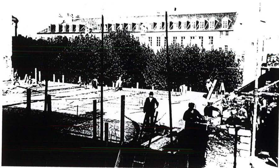
Rehaussement de 3 étages du bâtiment de la rue LANNOURON
