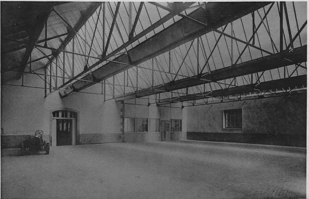
Vue intérieure des Ateliers (Réalisation de M. Bolo, Ingénieur A. M. R.)
