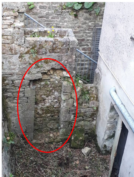
Vestige de la porte de l'aile nord donnant originellement accès à la cour est
