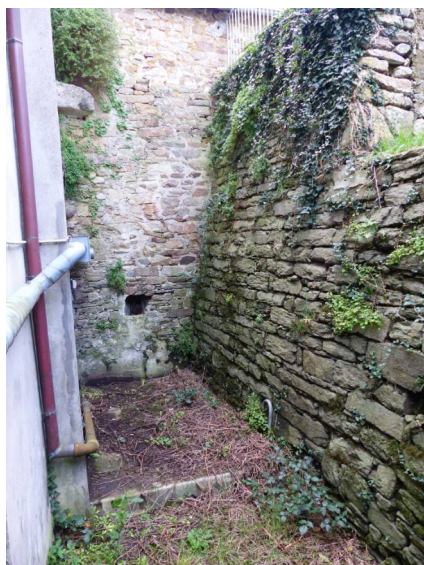
Mur de soutènement des terres du jardin
