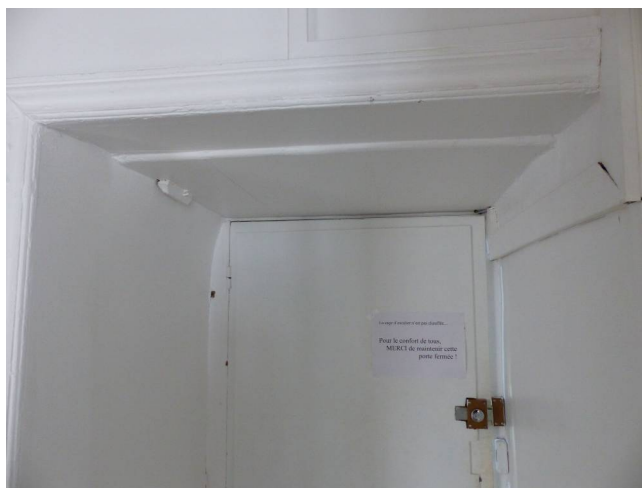
Passage entre l'escalier et le 2 e étage On y observe l'amorce d'un arc, probable vestige d'une ouverture ancienne.
