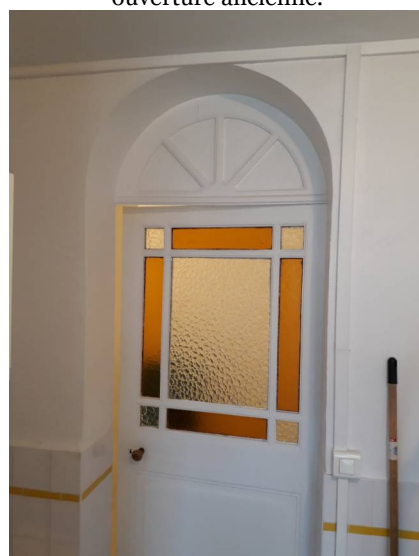
Passage entre le couloir et l'extension du XIX e siècle Vue extérieure L'arc en plein cintre des ouvertures originelles est toujours présent
