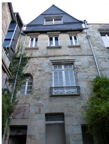
9 rue Kéréon, façade arrière
