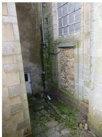
Chapelle des Jésuites, côté sud Accès (bouché) permettant l'accès au jardin
