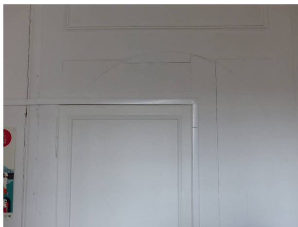
Trace d'une ouverture cintrée
