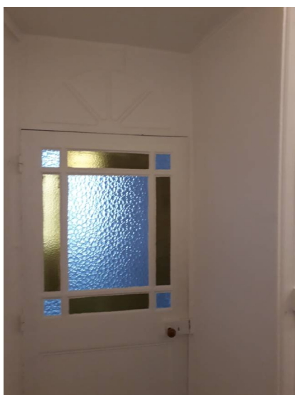
Passage entre le couloir et l'extension Vue intérieure
