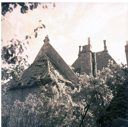
Aile nord, pignon de l'aile nord et couverture de l'appentis, 1959 115
