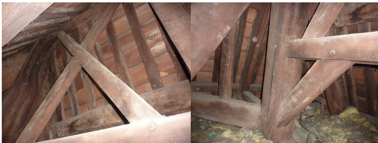
Maison du Pavillon, charpente
