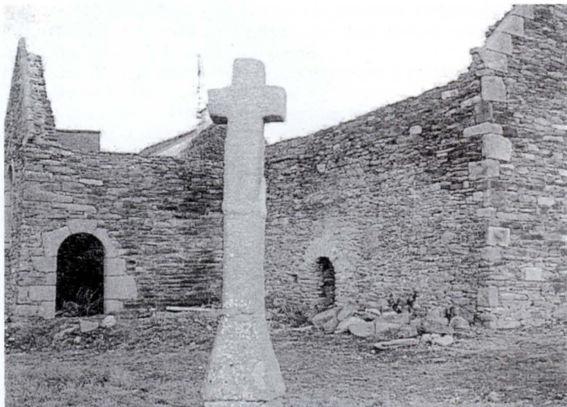
La chapelle Saint-Marc dans son état actuel. Dans quelques semaines, les Amis de la chapelle lanceront une dernière tranche de travaux de restauration.
