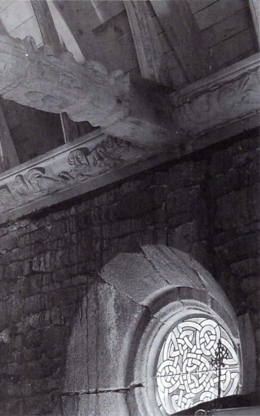
Détails de la charpente et des sablières de la chapelle Saint-Trémeur.
