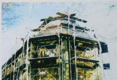
PENDANT LA POSE DE LA COUVERTURE
