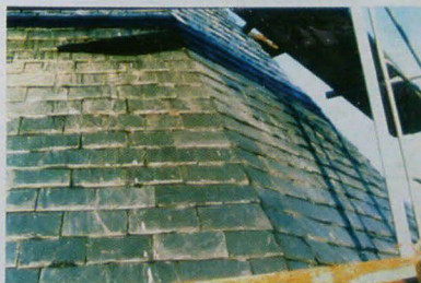
DETAIL DE LA COUVERTURE. EN ARDOISES EPAISSES
