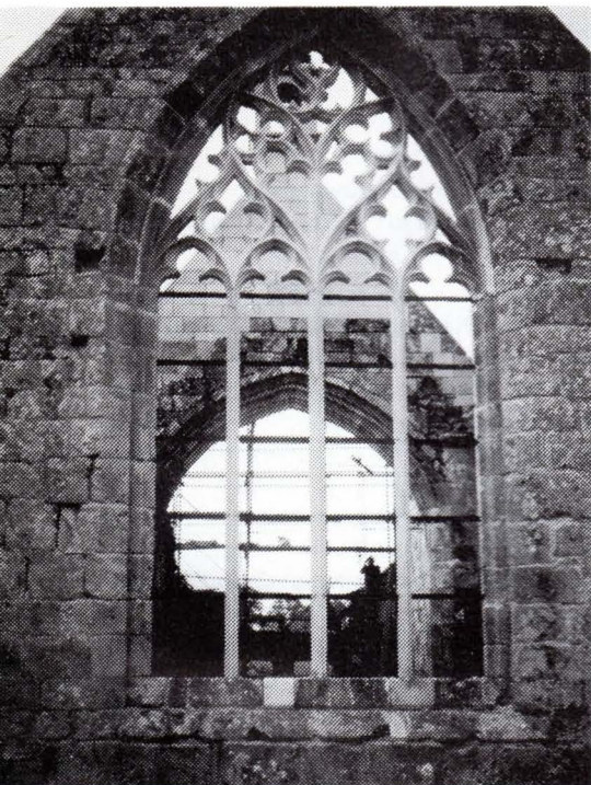
Notre-Dame de Gornevec, le pignon Ouest est entièrement descendu.
