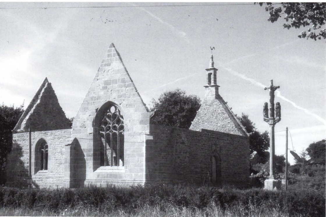
La chapelle de Christ après la première tranche des travaux.
