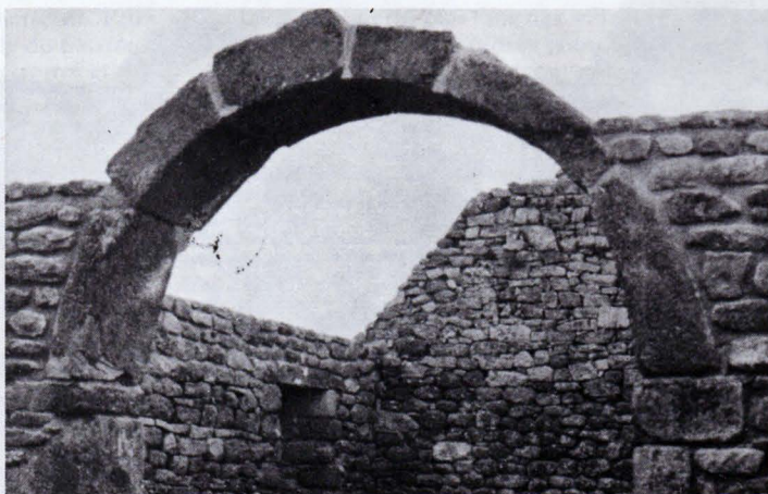
... La voûte reconstruite se dresse dans le ciel!
