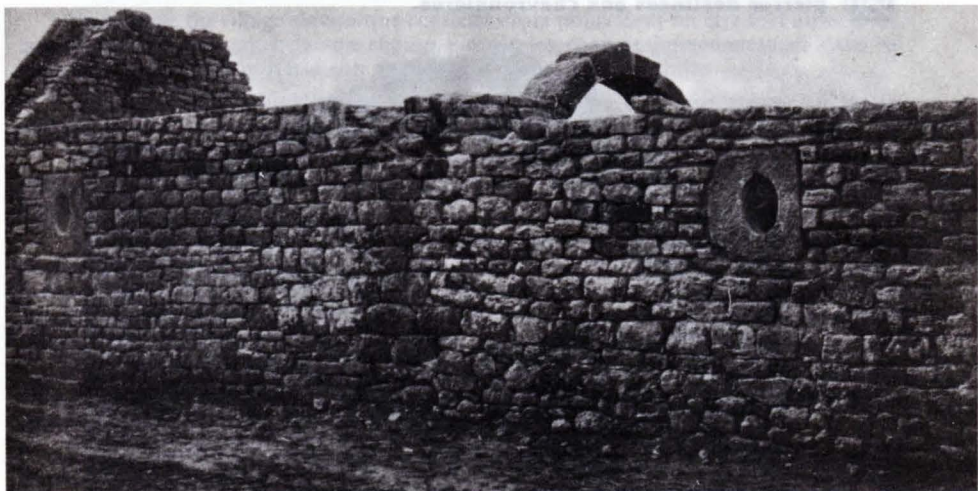
Été 1986... Murs nettoyés... Œils-de-bœuf en place
