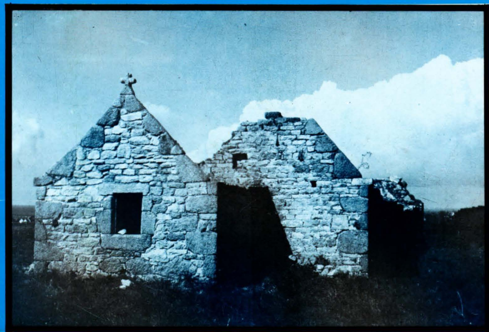
Saint-Ourzal, en Porspoder (Bro Léon) dans son état avant la restauration
