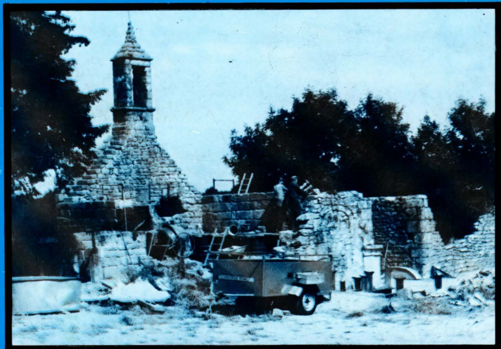
Le chantier de la chapelle de N.D. du Loc'h
