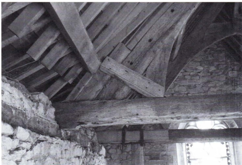
L'aspect de la charpente de la chapelle de la Trinité avant sa restauration.
