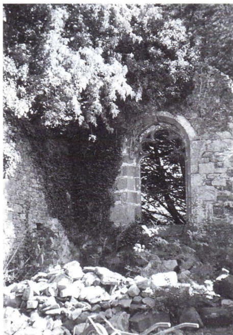
La fenêtre Sud du transept.
