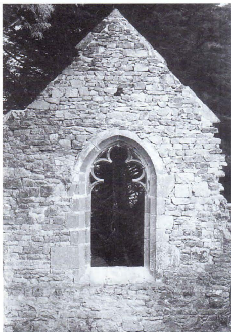
Le pignon Sud du transept remonté.
