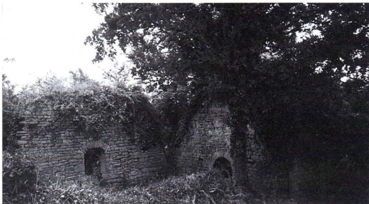
Après le débroussaillage, par les pionniers, les ruines apparaissent.
