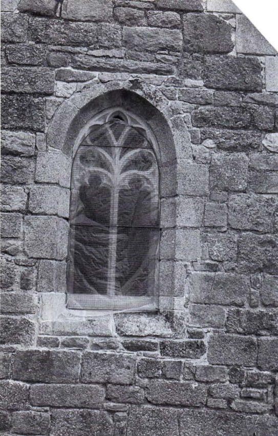
La fenêtre du chevet avec son nouveau remplage.
