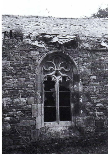
La fenêtre Sud de la nef et l'aspect délabré de la toiture.
