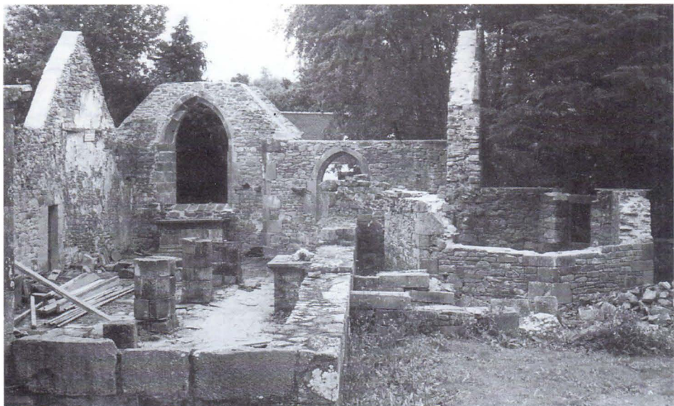
L'état des travaux de rénovation fin août.
