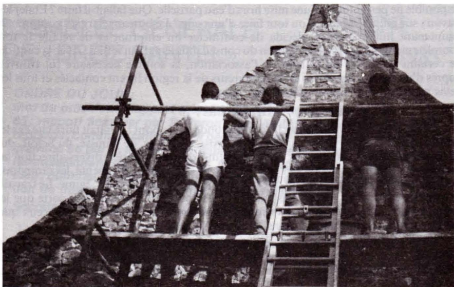
Le jointage des pierres en septembre 1985.
