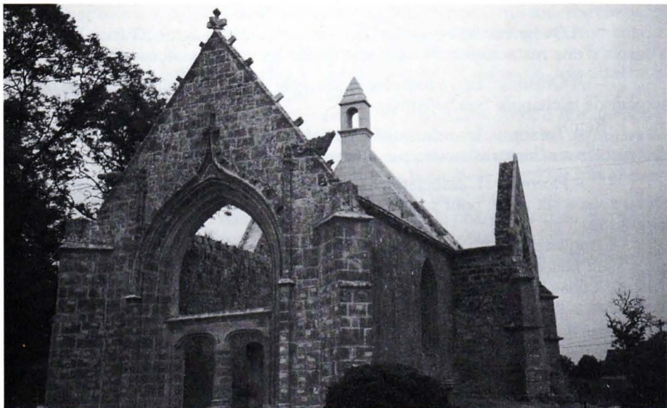
A Plumergat, la maçonnerie de la chapelle Notre-Dame de Gornevec est terminée.
