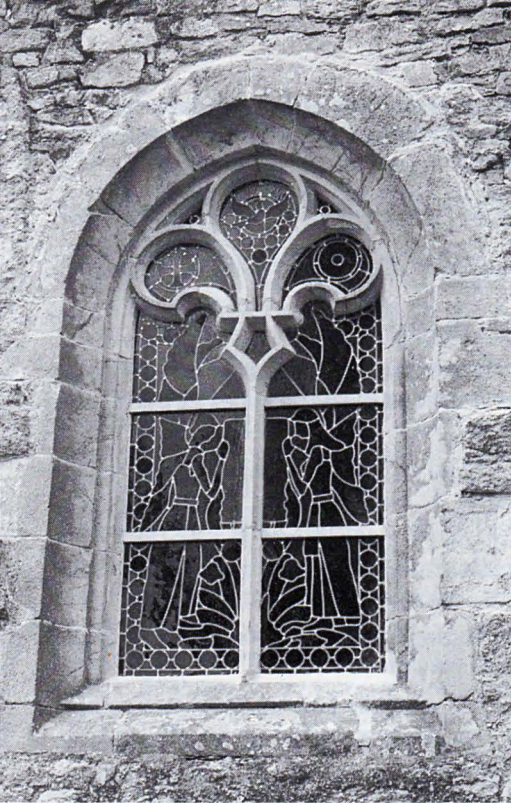
La chapelle de la Trinité au Moustoir en Pluvigner. La fenêtre Sud après sa réfection.
