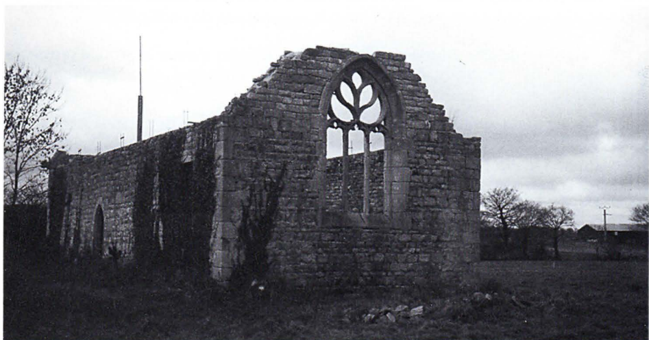
La chapelle Saint-Tugdual en Plouagat. La réfection de la maçonnerie est presque terminée.
