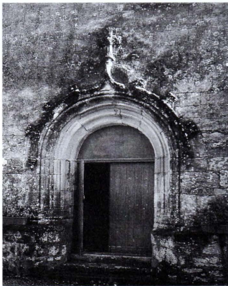
Le portail de la chapelle Notre-Dame de la Recouvrance à Surzur.
