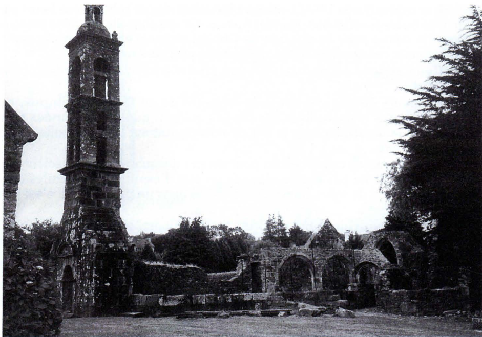
La chapelle de Lanvoy à Hanvec. Vue d'ensemble de la restauration des arches de la nef.
