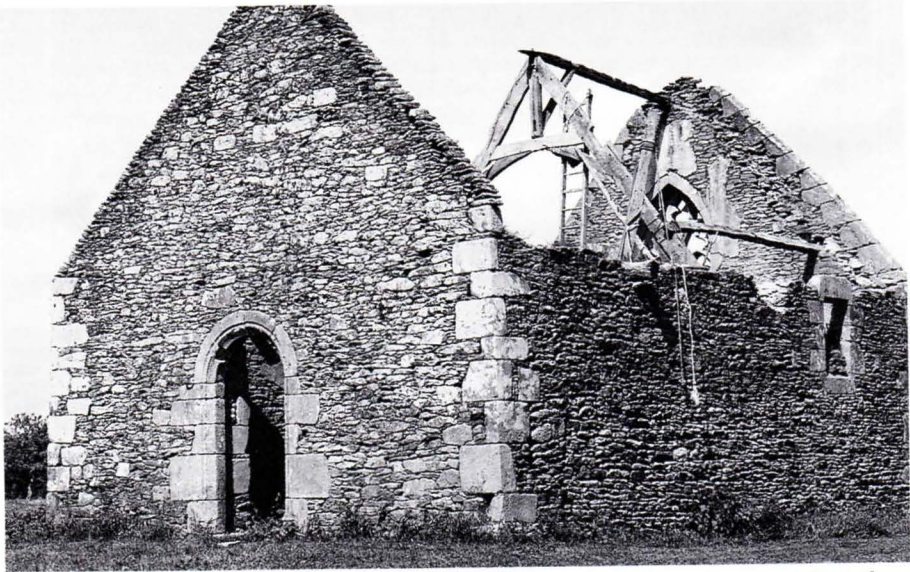
L'état de ruine de la chapelle du petit manoir de Susicinio avant sa restauration providentielle !
