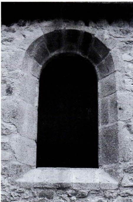
FENÊTRE SUD DU CHŒUR
