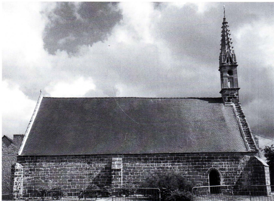
La chapelle Saint-Guérolé à Ergué-Gabéric. Le rejointement des pierres est terminé et le clocher est restauré.
