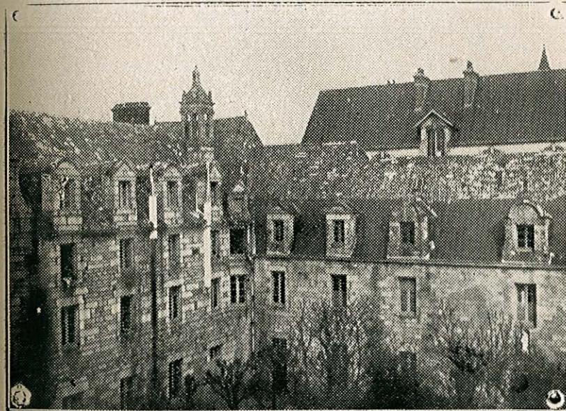
INTÉRIEUR DES BATIMENTS
