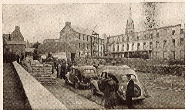
L'arrivée des anciens dans la cour des petits. Au fond : les ruines de l'Asile des Vieillards.
