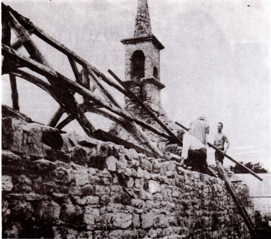
En septembre 1968, Gérard Verdeau (tonse nu) en pleine action sur la charpente d'une chapelle bien délabrée de Pluvigner, Morbihan. (Photo archives Breiz Santel.)
