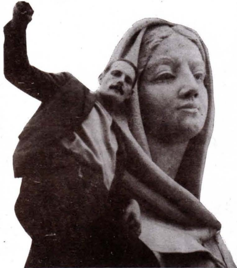
Notre fondateur au sommet de la basilique de Sainte-Anne d'Auray avant la descente de la statue de Sainte-Anne, lors des travaux en 1974. (Archives Breiz Santel.)
