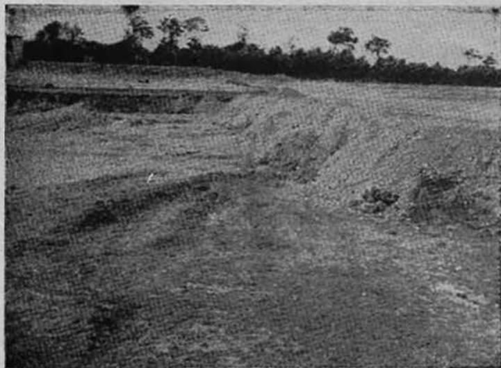
Une vue des travaux
