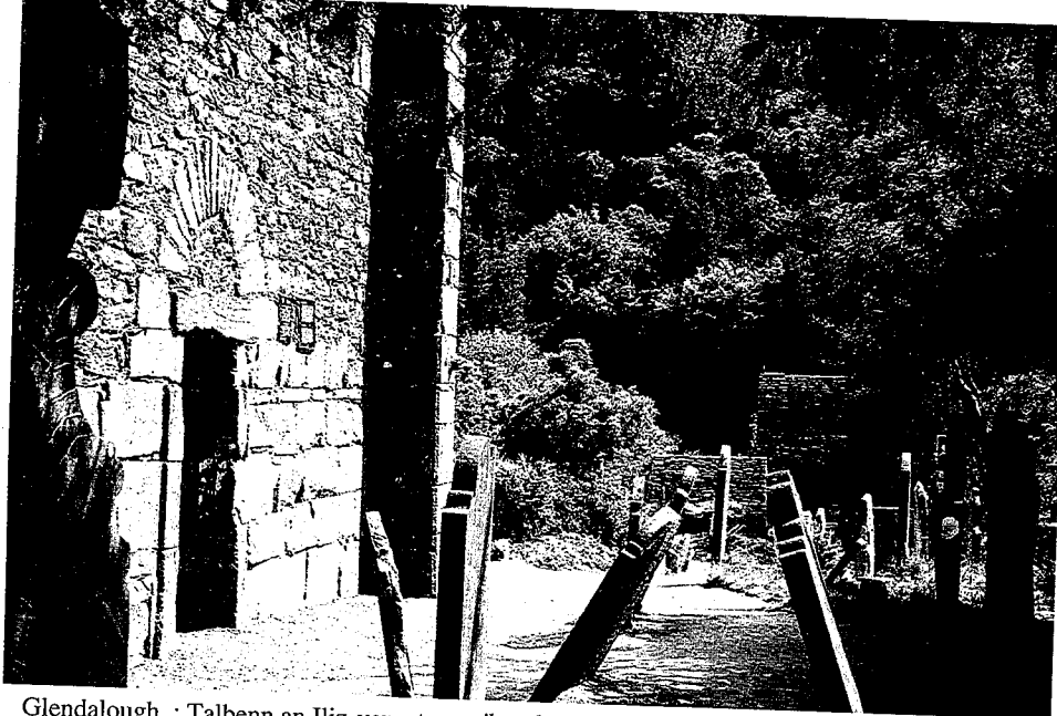
Glendalough : Talbenn an Iliz-veur, tu ar c'huz-heol. Traoñ ar mogerioù, a bep tu d'an nor, 'zo savet gand mein braz. Ar pilieri diavêz a vez anvet "antae". Er foñs, toenn iliz Sant Kevin. Façade ouest de la cathédrale. La base des murs des deux côtés de la porte est faite de gros blocs parfaitement agencés. Les contreforts portent le nom d'Atae. Au fond, la toiture de l'église Saint Kevin.
