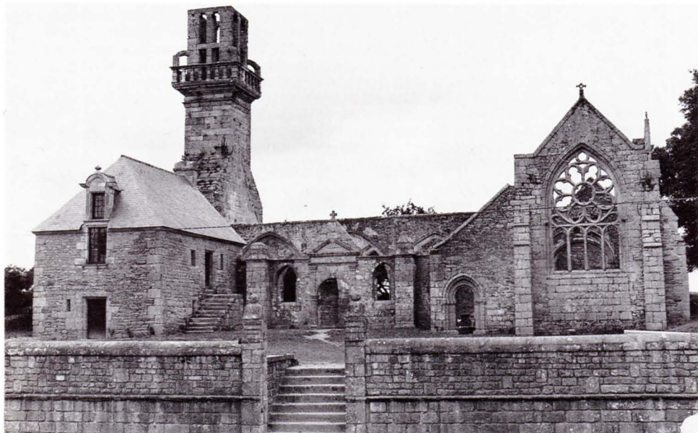
Après le débroussaillage inouï, la toilette du sanctuaire est refaite... Le presbytère reconstruit...
