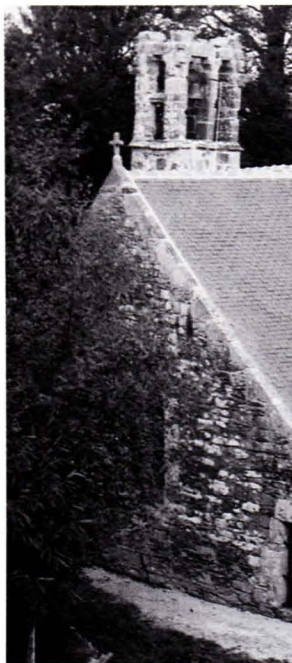
Commencée en 1987, la toiture de la chapelle du Moustoir est superbe, terminée en août 1988.
