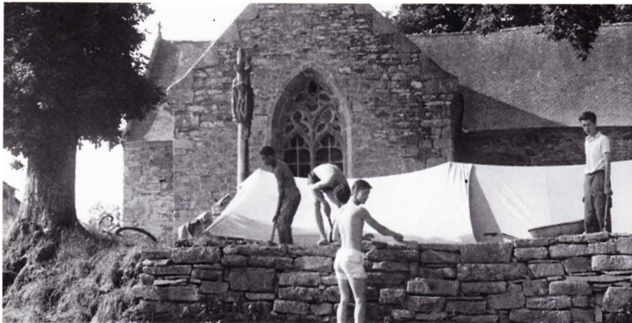
Été 1986. Réfection au Moustoir d'un mur extérieur par des bénévoles.
