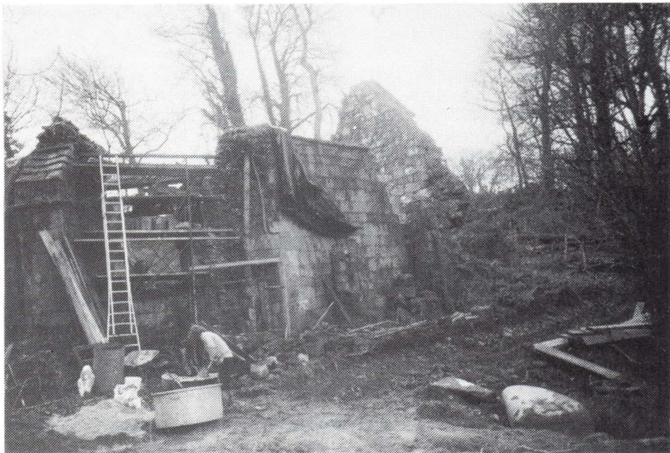
Chapelle Saint-Hervé à Plélauff en Côtes-d'Armor en cours de restauration. Reconstitution du chevet.
