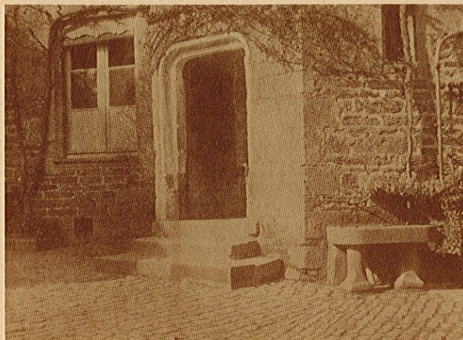
Vue de la cour intérieure avant 1880.
