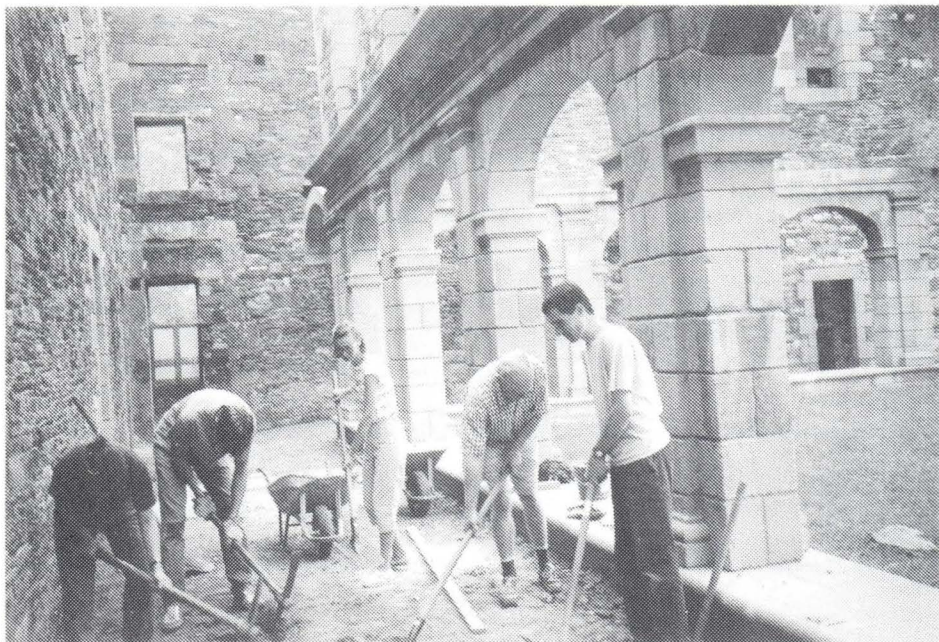
Une équipe de bénévoles au travail sur le chantier.
