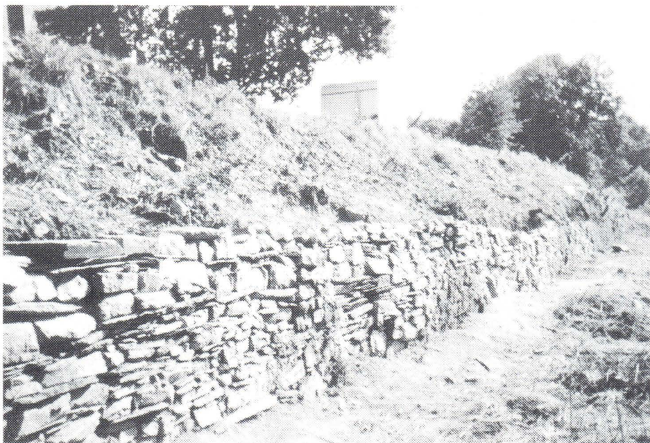
Le mur refait par les scouts
