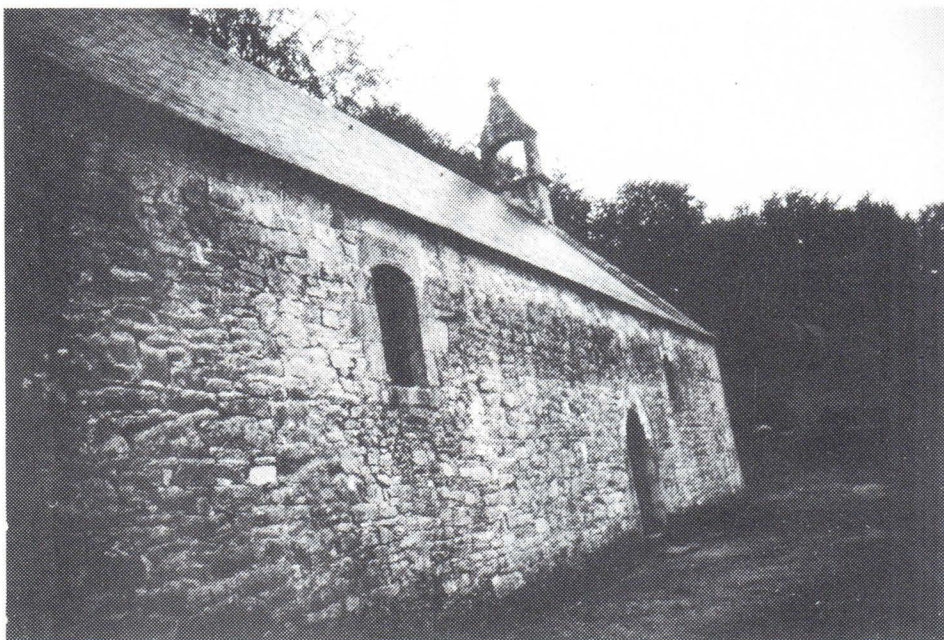
La chapelle de Kerdrouallan après sa rénovation.
