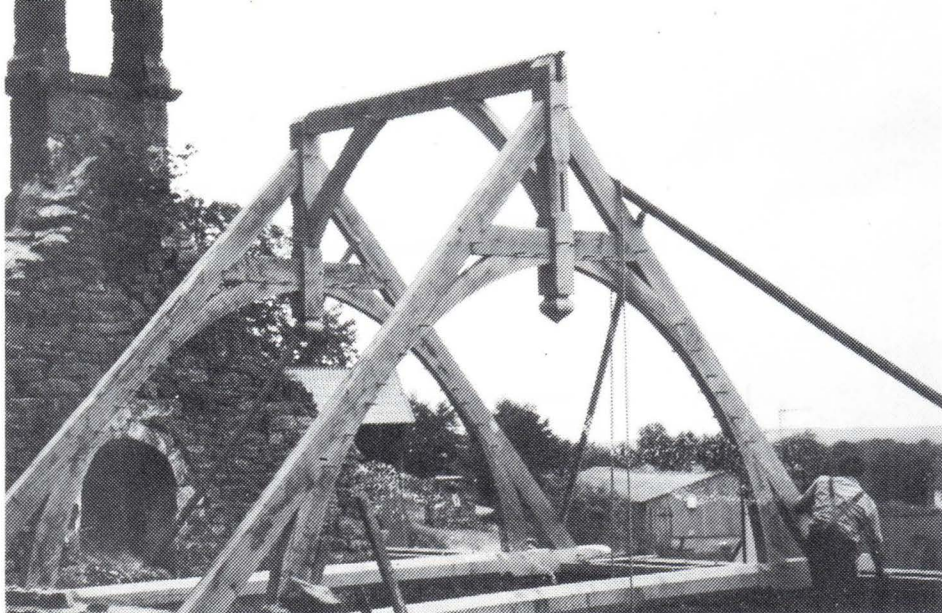
Notre-Dame de Kerdrouallan. La charpente nouvelle, un travail remarquable.
