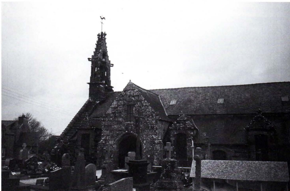
L'église paroissiale de Quemperven en Côtes-d'Armor.
