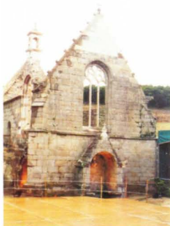
MISE EN PLACE DES PIERRES REPERTORIEES, AVEC UN COMPLEMENT DE PIERRES TAILLEES DANS LA ROCHE SUR PLACE
