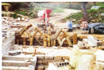
MISE EN VALEUR DES RESTES DU XIII e SIECLE TROUVEES DANS LES TALUS ET DANS LE REMBOURRAGE DES MURS
