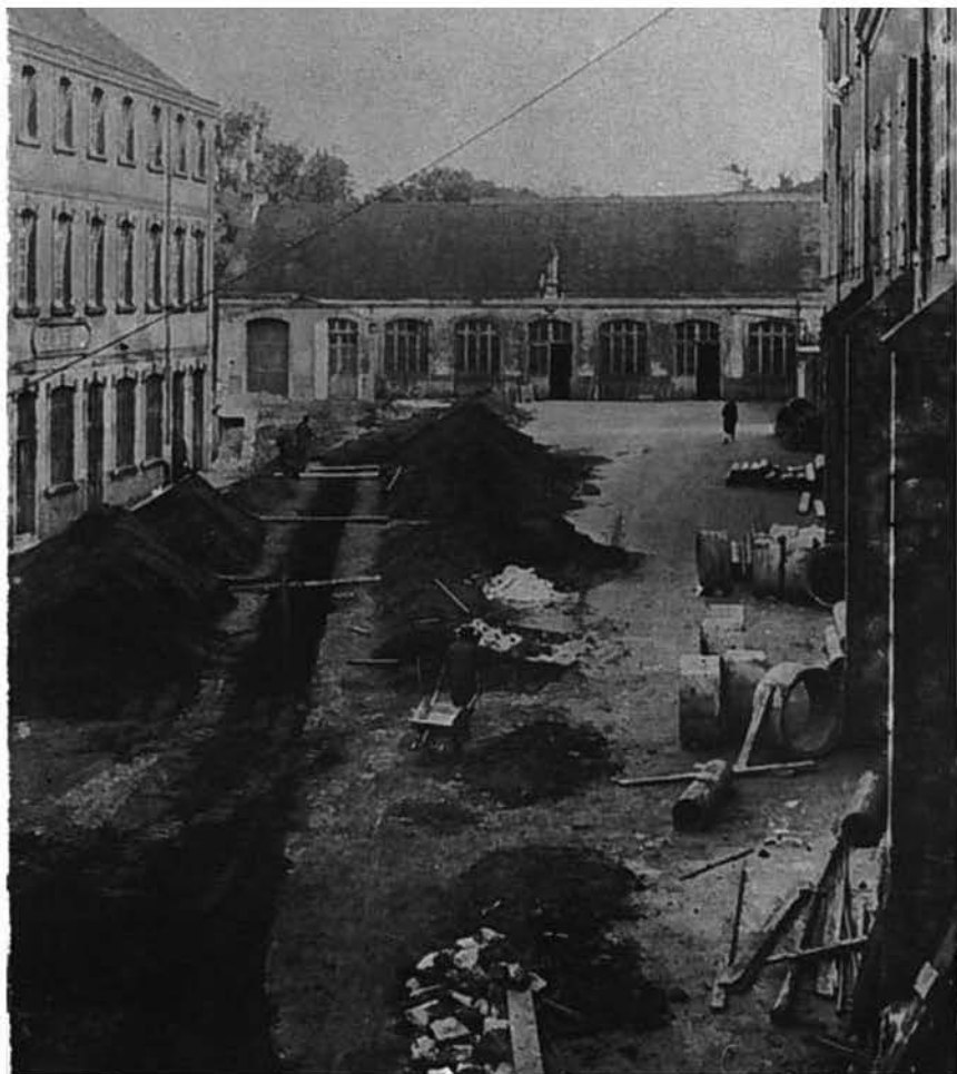
TRAVAUX DE VACANCES
