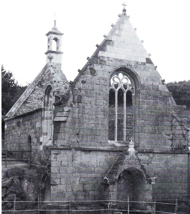
La chapelle avec le nouveau remplage de la fenêtre Sud.
