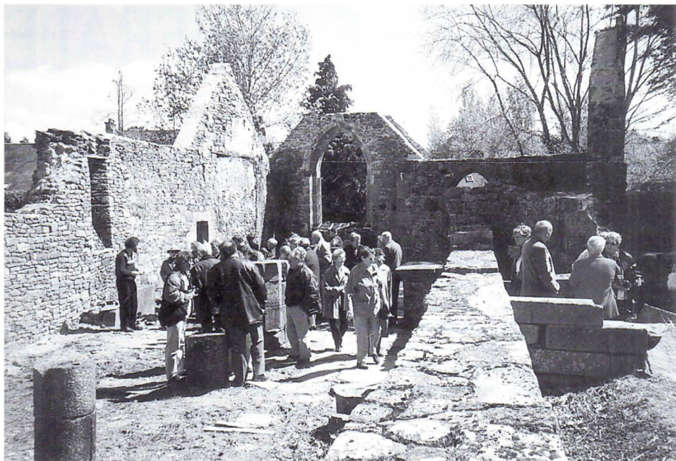
Vue d'ensemble de la chapelle de Lanvoy à son stade de restauration.
